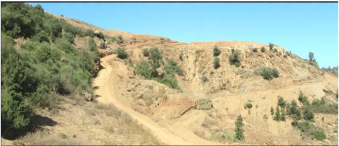
Photo III.3 : vue de la zone entre pk17+067-pk17+466.
