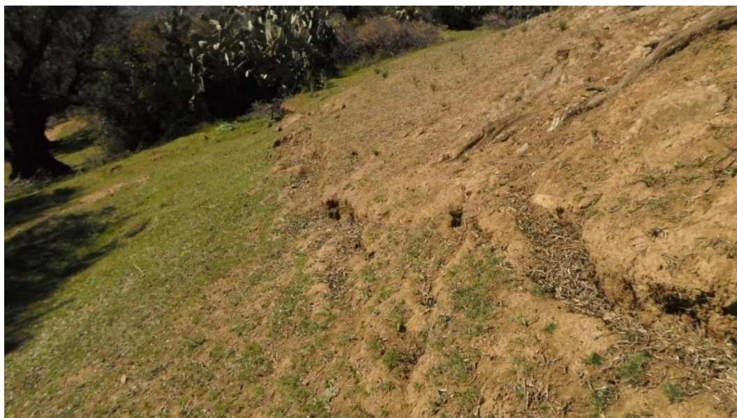
Photo III. 8 : vue de la fissure latérale gauche.
