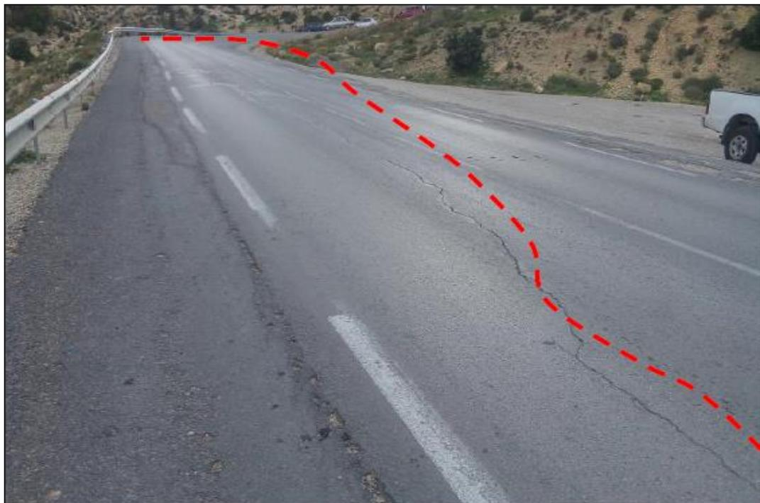
Figure 4-4 État de la chaussée dégradée.
