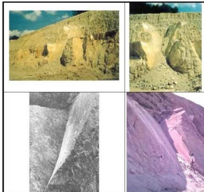
Figure II.14 - Exemples de rupture de dièdres.
