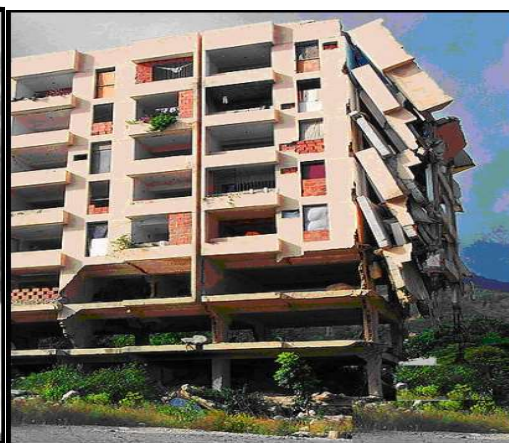
Figure I.13 : Construction partiellement Seca Venezuela 1999 [13]
