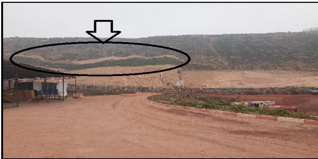
Figure I.15 : glissement de terrain 2019 à Mersa el Kebir à Oran
