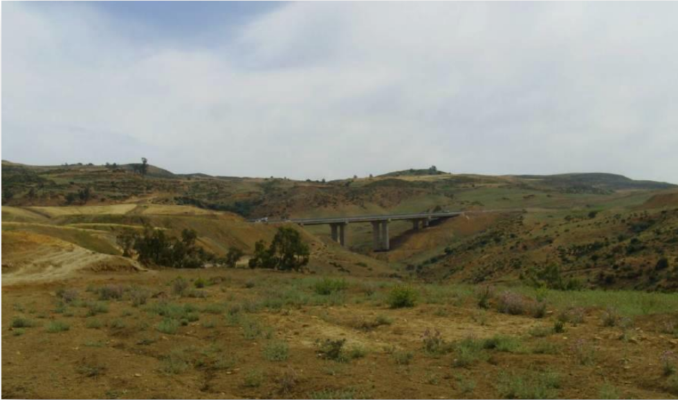
Figure III.4 : Affleurements de grès du Miocène au niveau de l'autoroute Est-Ouest [33]
