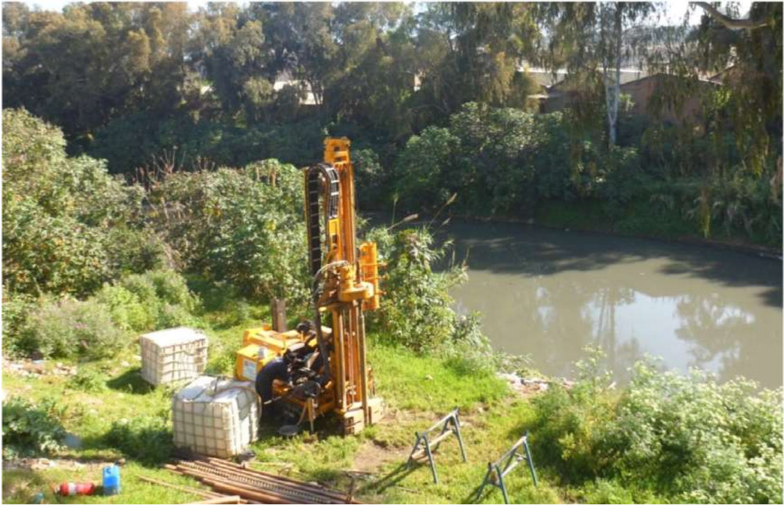
Figure 29. Localisation du Sondage BBH-168.
