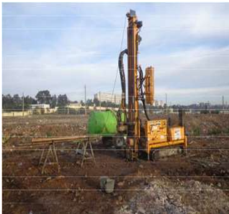
Figure 19. Photographie d'un atelier de sondage carotté [28].
