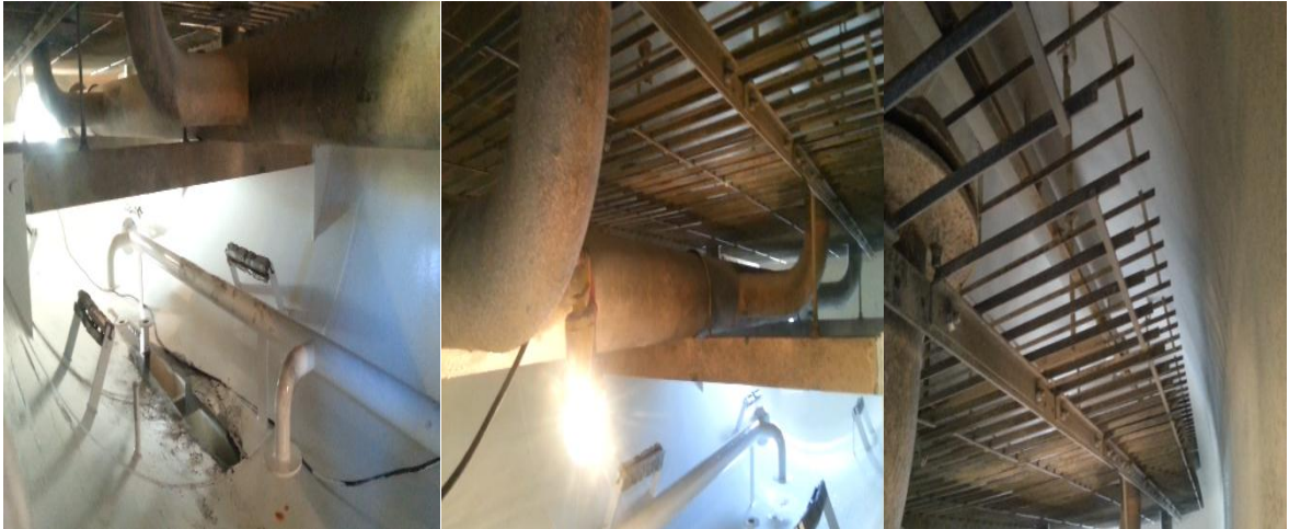
Figure III-5 : Les tuyauteries du dessaleur après nettoyage et peinture [20]
