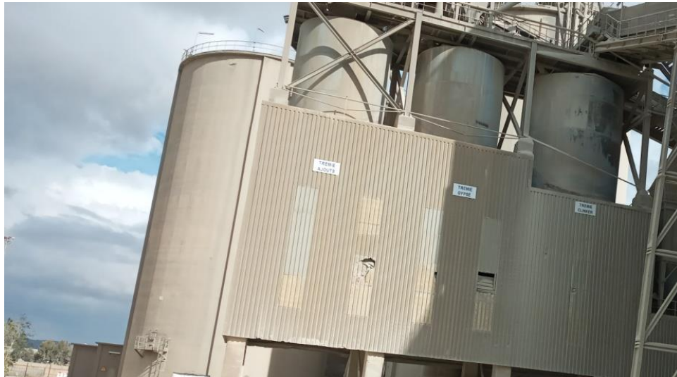
Fig II-12: Trémie de dosage (clinker, gypse et ajouts).
