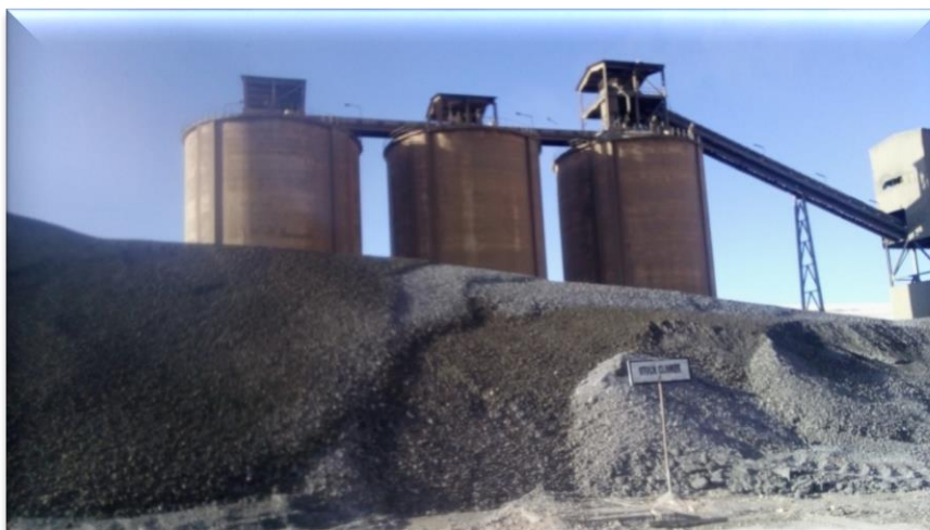
Fig II-11: Silos de stockage du clinker.
