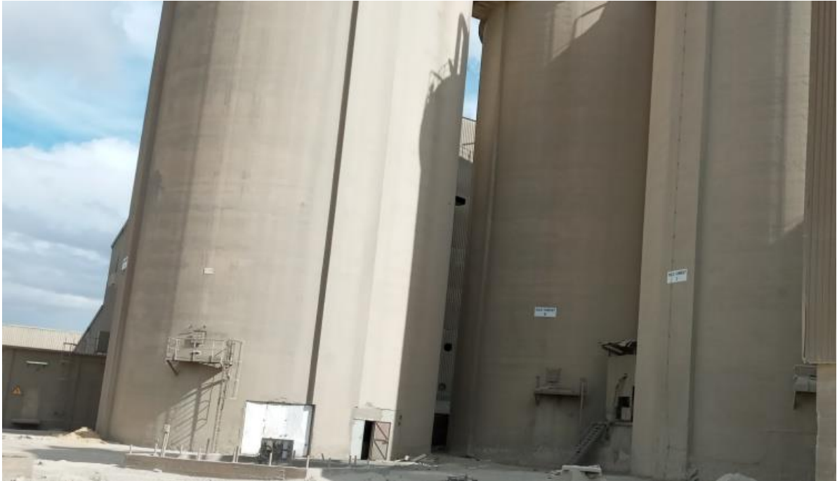
Fig II-13: Silos de stockage ciment – cimenterie d'Elma Labiod – TEBESSA -.
