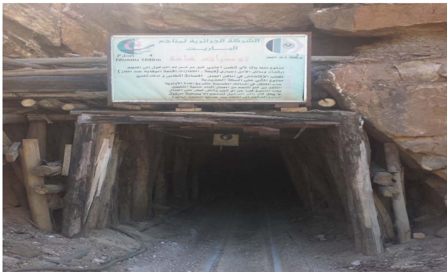
Figure II.10: L'entrée de la galerie du niveau 1690 m. [12]
