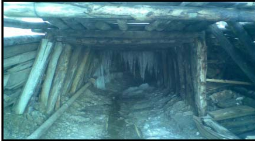
Figure II.09 : L'entrée de la galerie du niveau 1730 m. [12]
