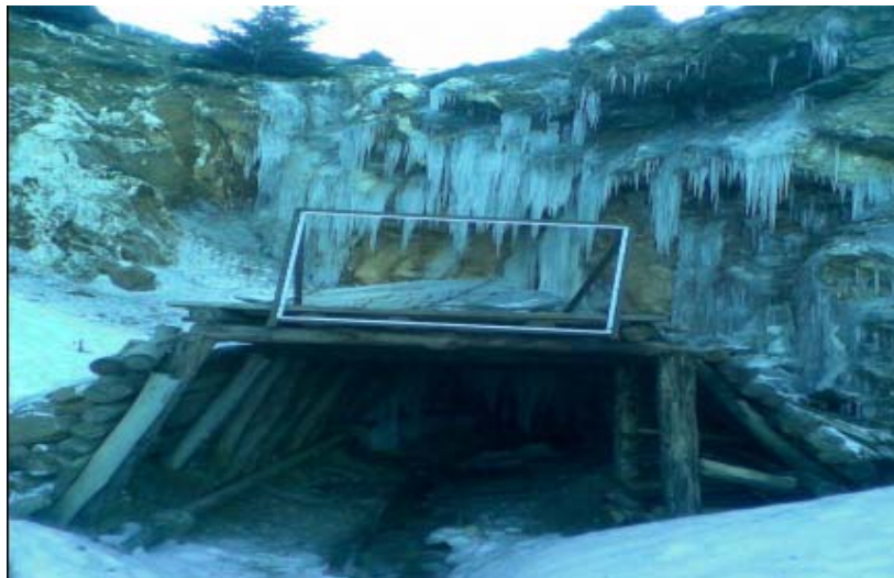
Figure II.08: L'entrée de la galerie du niveau 1770 m. [12]
