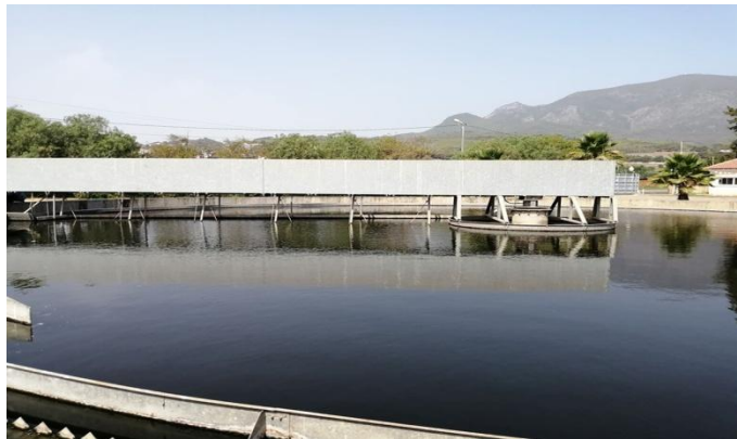
Figure I.16 : Bassin de décantation. (PP).
