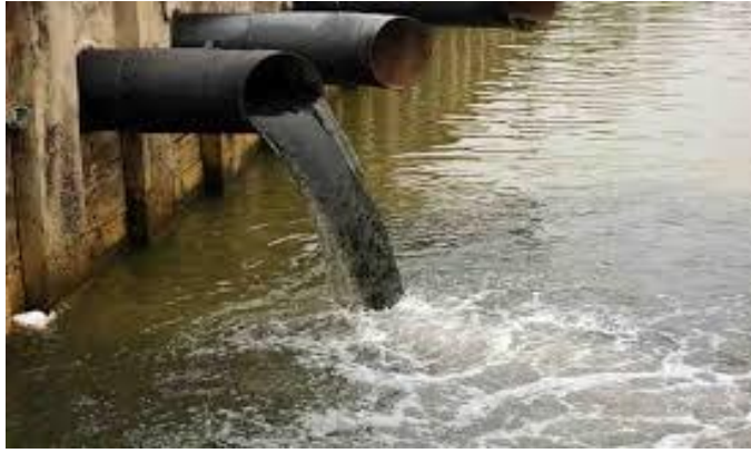
Figure I.2 : Les eaux Industriels
