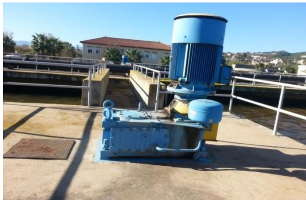
Figure I.15 : Aérateur. (PP).
