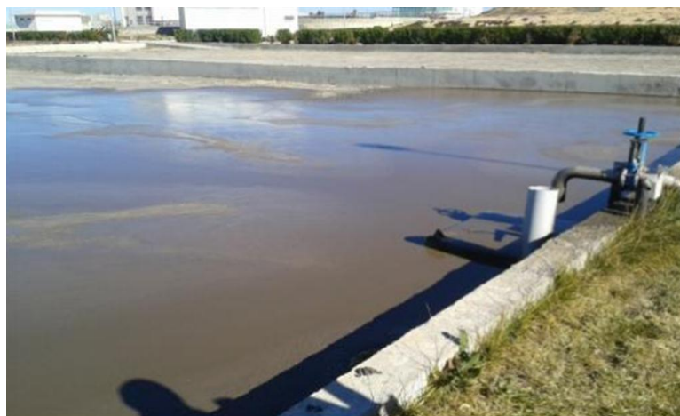
Figure II-12 Lits de séchage.
