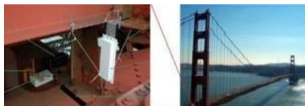
Figure 1.7 Contrôle des structures Golden Gate Bridge [10].
