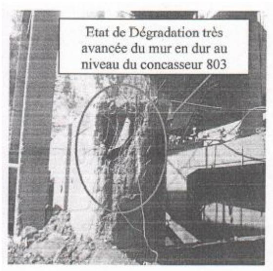
Figure 2.29 : états de dégradation très avancée du mur en dur au niveau du concasseur 803
