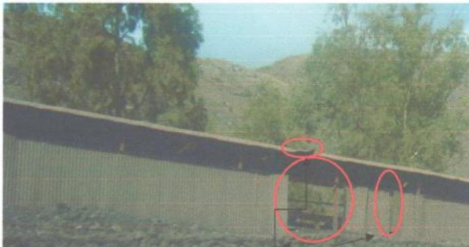
Figure 2.12 : Photo illustrant la dégradation des éléments du capotage du convoyeur à bande
