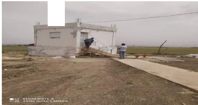
Figure 20 : Source d'eau bache à eau
