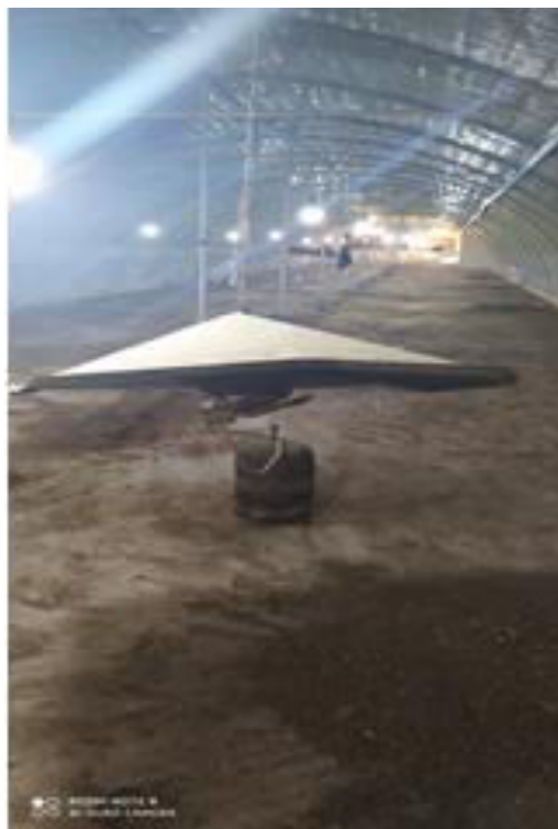
Figure 18 : chauffage à gaz
