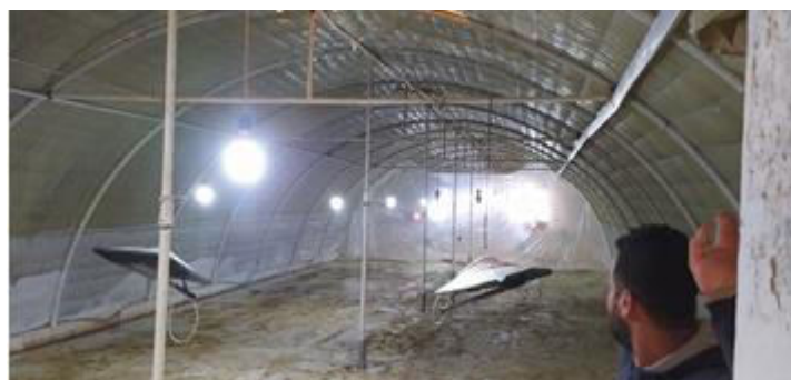
Figure 16 : Bâche de séparation
