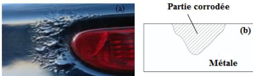
Figure 9 : Corrosion Localisée : a) Image réelle ; b) Schéma.
