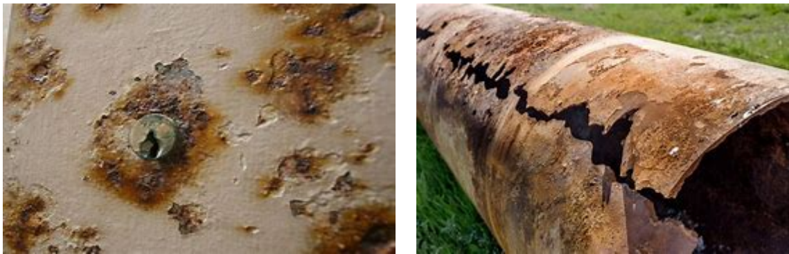
Figure- I.7. Exemple de corrosion sélective.
