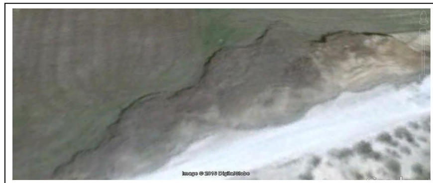
Fig 3.03 : glissement de Zaarouria RN 16 (photo sautillée 2015).
