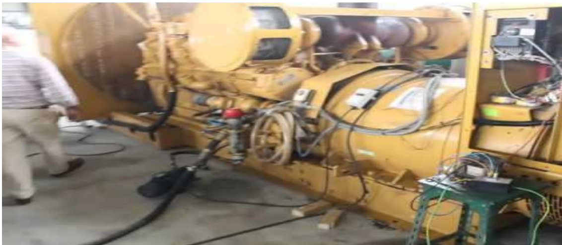
Figure.V.1. groupe électrogène CAT 3512. [36]
