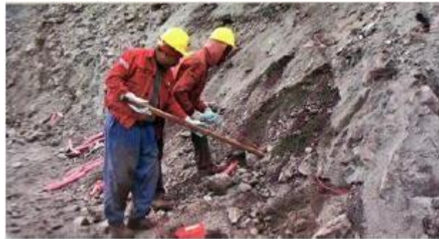
Figure IV.6 : Chargement des trous forés avec l'explosif.
