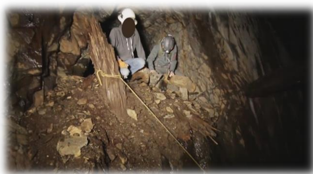
Figure II.7 L'éboulement dans souterrain.
