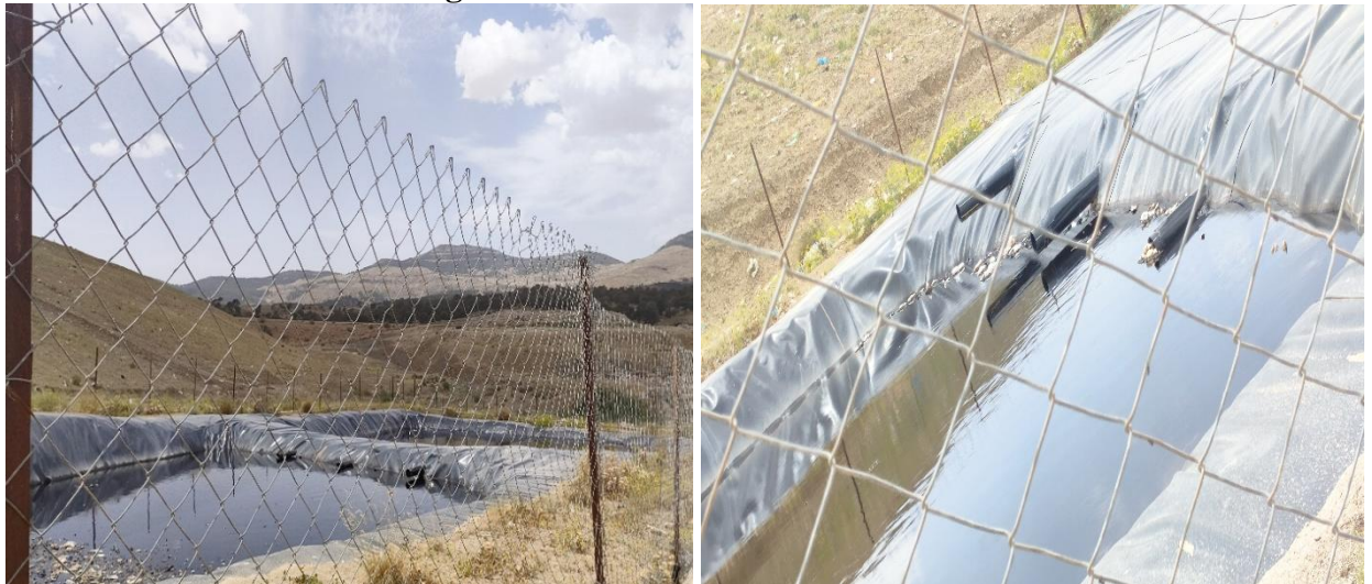
Figure 18: Les bassin de décantations
