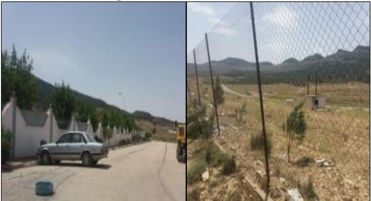
Figure 11: La clôture du CET Tébessa
