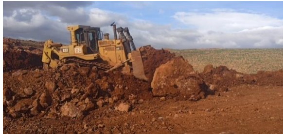
Figure II-16: bulldozer (bull CAT D9).
