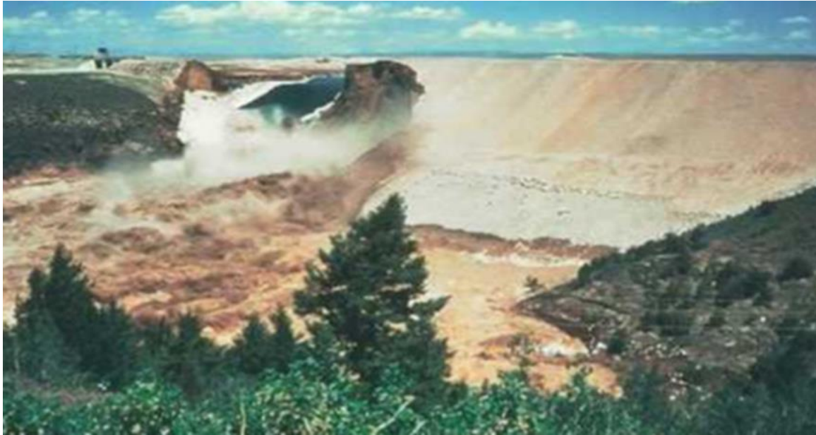
Photos N11 : Rupture du barrage de Teton, Etats-Unis (TETON HISTORY,1998).
