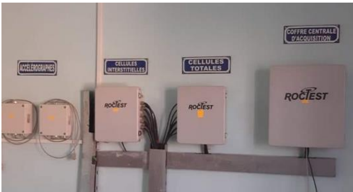
Photos N° 20 : Raccordement des appareils de mesures à l'aide des câbles au bâtiment de commande.
