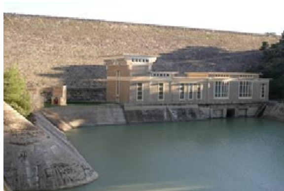
Photo N°8 : Barrage à masque amont en Béton de Ghrib W. Ain Defla. (opodoran.canalblog.com)
