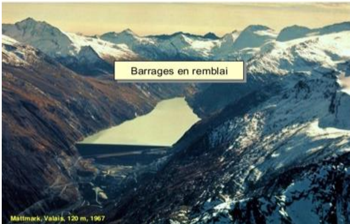
Photo N° 1 : Barrage de Mattmark, Valais de 120 m, 1967 en remblais (fr.slideshare.net)
