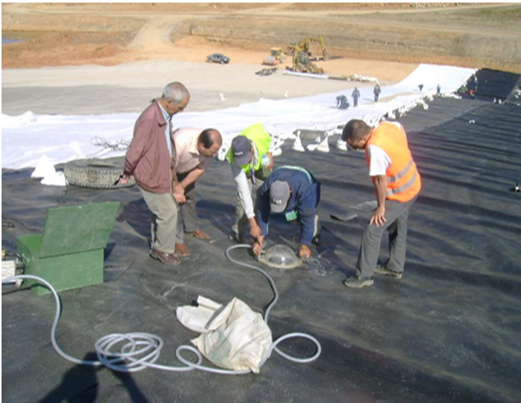
Photos N° 17 : Contrôle des joints de la géo membrane, par l'air comprimé (Présentation du barrage d'Ourkiss, 2011).
