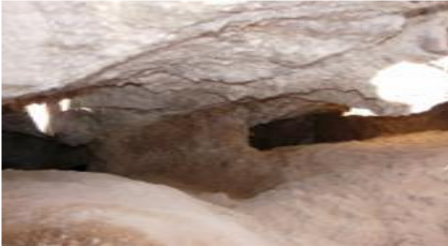
Photos N13 : Fractures ouvertes, karstifiées avec des concrétions calcaire (Présentation du barrage d'Ourkiss,2011).
