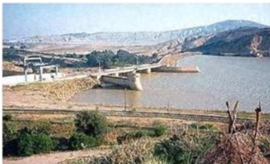
Photo N°10 : Barrage Fergoug après la reconstruction en 1986 (in merise 18191.skyrock.com)
