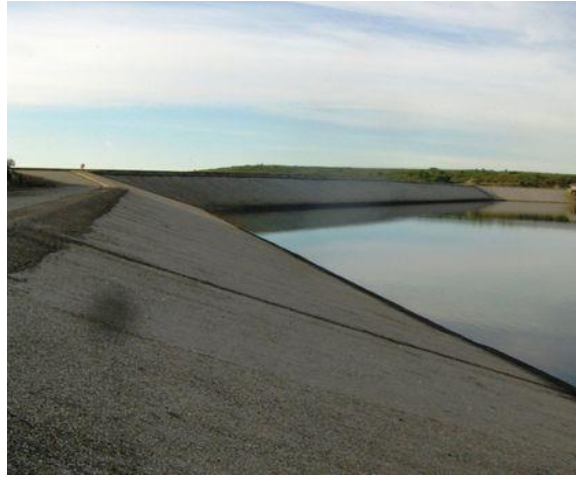
Photo N°6 : Masque en béton bitumineux du bassin de Vallon d'OL (Photos Irstea-G2DR)
