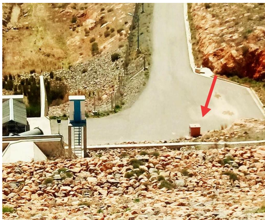
Photos N° 25 : Dispositif de drainage du barrage d'Ourkiss.
