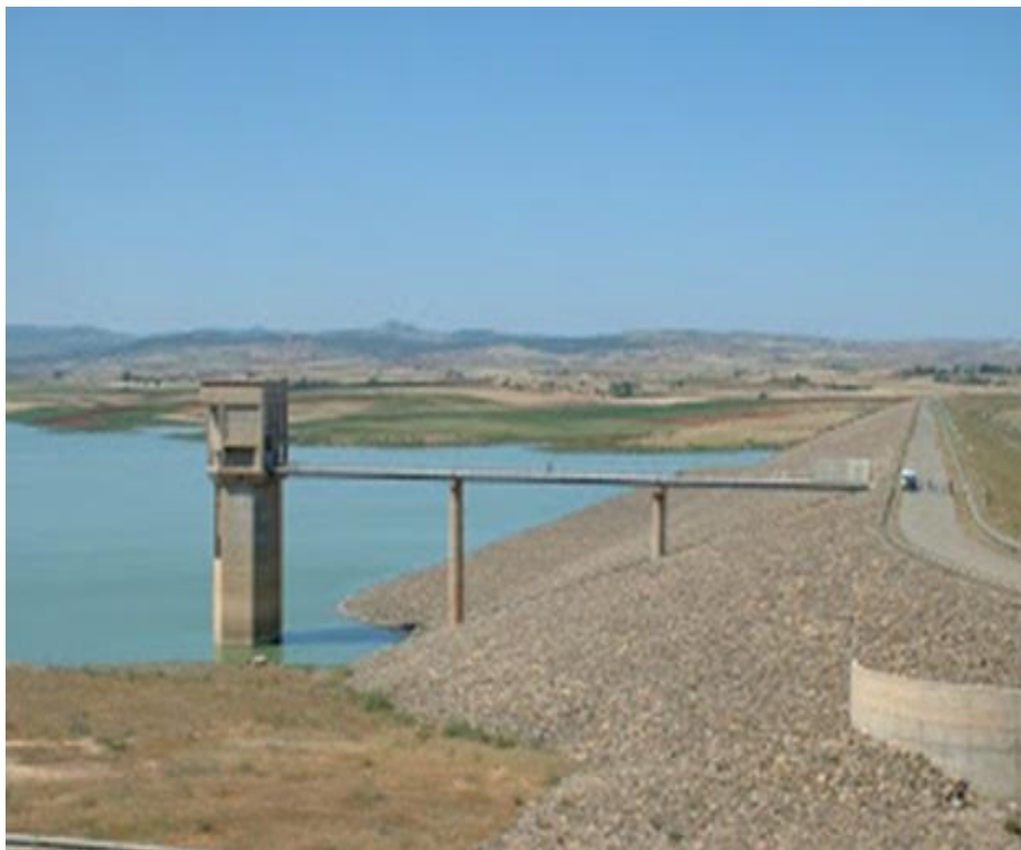
Photo N° 3 : Barrage en terre homogène de Herraça, W. Chelef (in postesdeoehenalgerie.blogspot.com)
