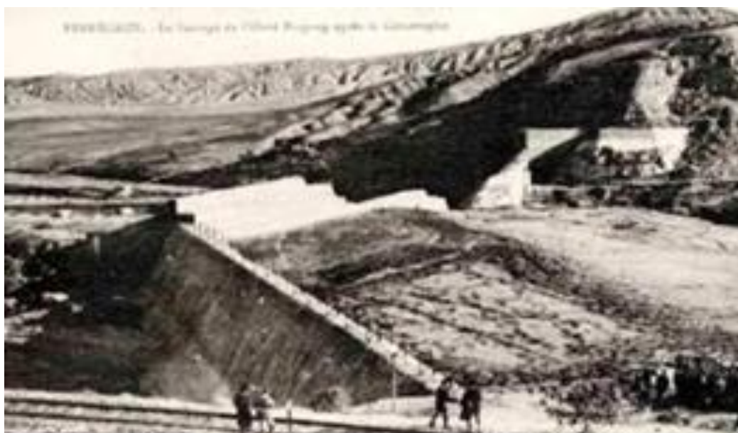
Photo N°9 : Barrage Fergoug après la rupture par déversement en 1928. (in docplayer.fr)
