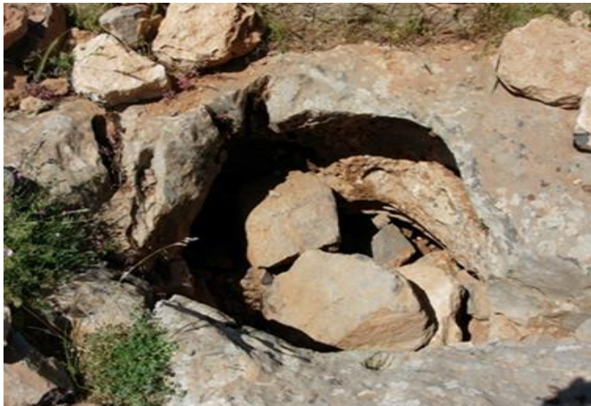
Photos N° 14 : Fractures, karstifiées dans les calcaires dolomitiques de la surface de la zone du barrage (Mémoire de synthèse site du barrage d'Ourkiss, 2003)
