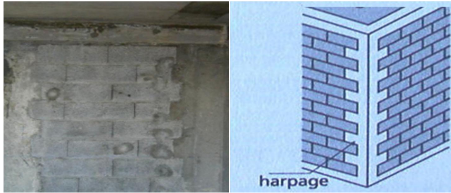
Fig. 1. 1. 5 : La maçonnerie chaînée en harpage [6].
