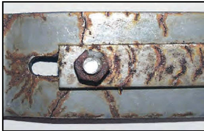
Figure I. 8 : Corrosion sous contrainte
