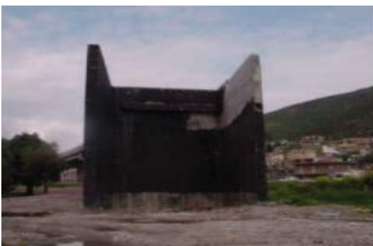
Vue de l'Ouvrage d'Art
