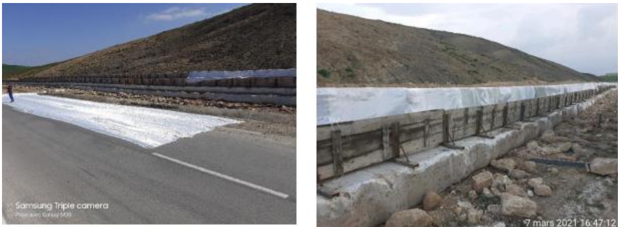
Figure 2.4 : Utilisation du géotextile dans le renforcement.[3]
