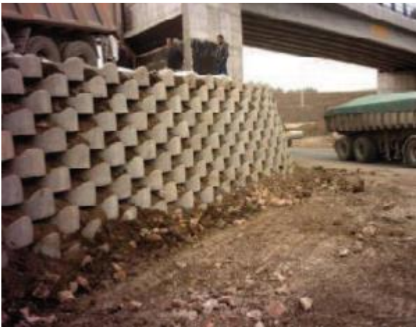
Vue de l'Ouvrage d'Art
