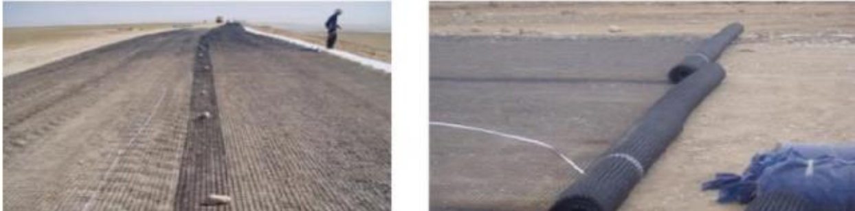
Figure2.5 : Utilisation du géogrille dans le renforcement.[3]
