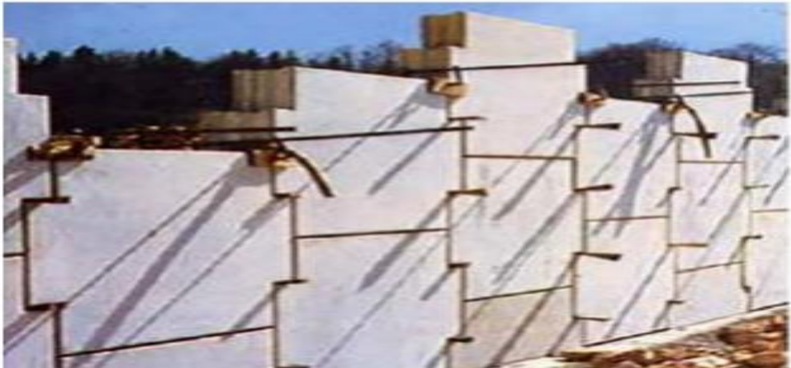
Figure 2.13: Photo du montage d'un niveau d'éléments de parement [8]
