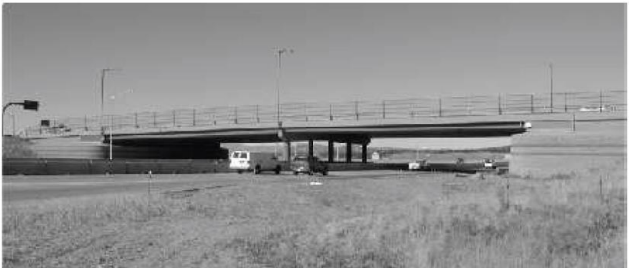
Figure.4.2. Vue générale de l'ouvrage en service de pont de Founders/Meadows (Abu-Hejleh et al.2002) [12]
