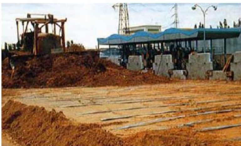
Figure 2.14 : Photos du remblaiement et du compactage d'une couche de sol [8]
