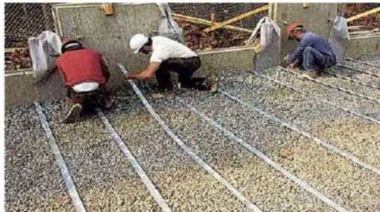
Figure 2.15: Photo de la pose d'un lit d'armatures.[8]
