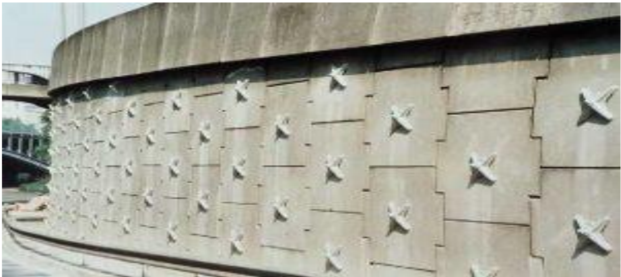
Figure 2.8 : le parement de mur en terre arméé [9]
