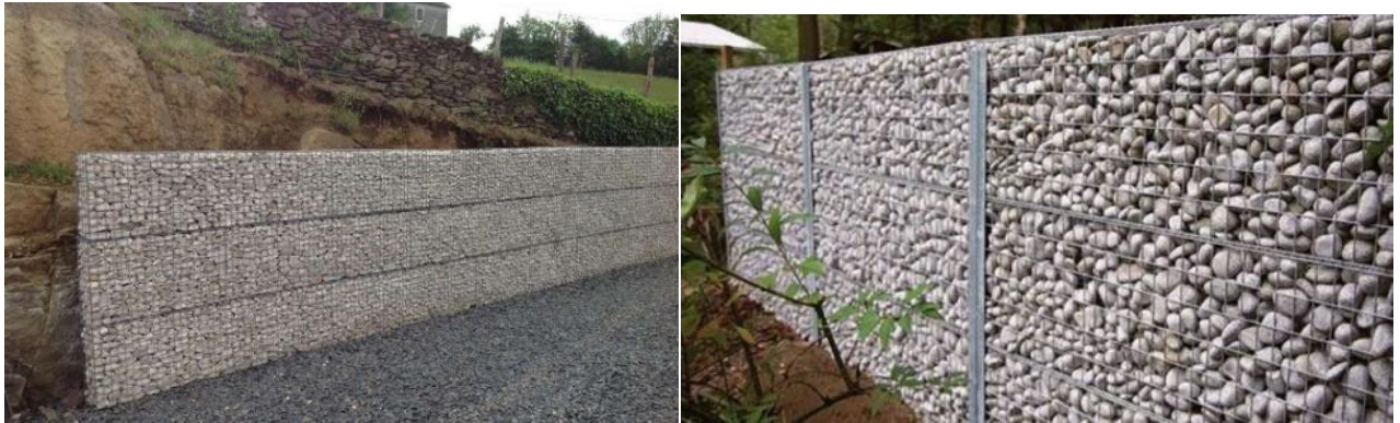
Figure 1.17 : Renforcement par grillage ou treillis métalliques. [20]
