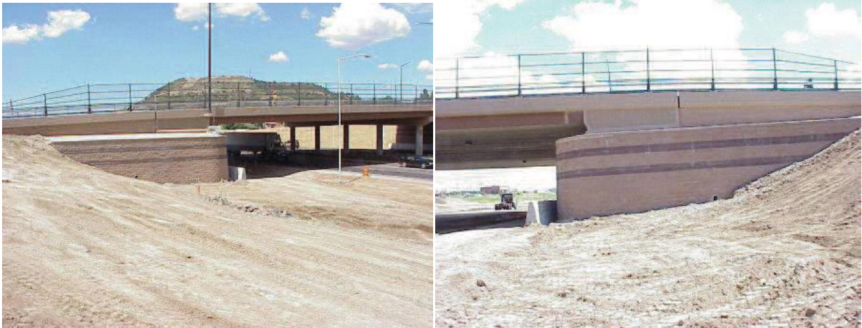
Figure.4.1. Vue de l'ouvrage achevé de pont de Founders/Meadows (Abu-Hejleh et al. 2000) [12]
