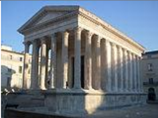
Maison Carrée de Nîmes
