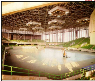
Fig. 63: Treillis a trois dimensions en éléments de série (nœuds et barres)
