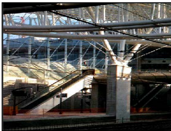
Fig. 62 : Les barres constituent des treillis spatiaux plans ou courbes
