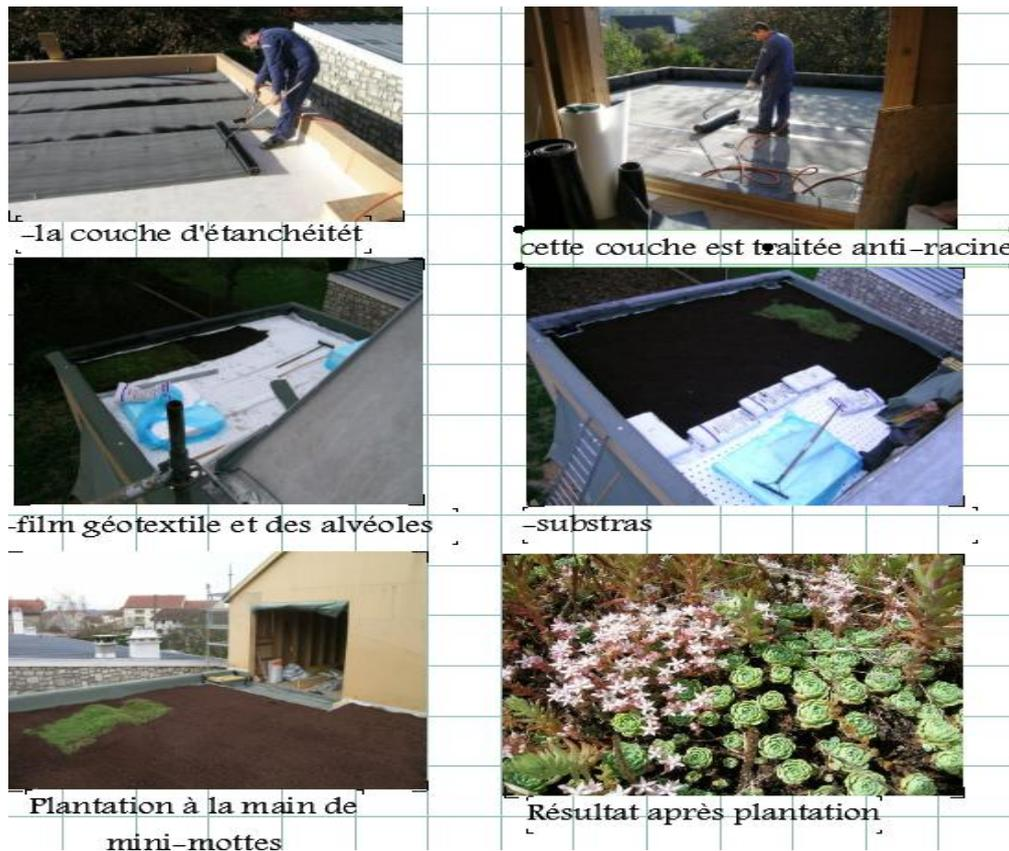
Figure 3 : les étapes de réalisé une toiture végétale.
