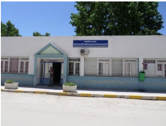
Photo 17: façade de rectorat Source : auteur10 /05/2015
