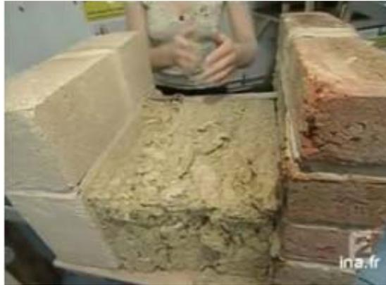
Figure 28 : mur en trois épaisseurs; béton + brique pleine + 30 cm de laine de roche, Vauban, (Allemagne).
