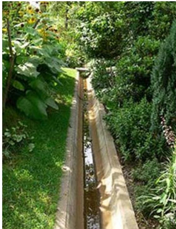
Figure 52: les eaux ruissellement des axes circulants sont collectées et épurées à part, Eva Lanxmeer, (Pays-Bas).
