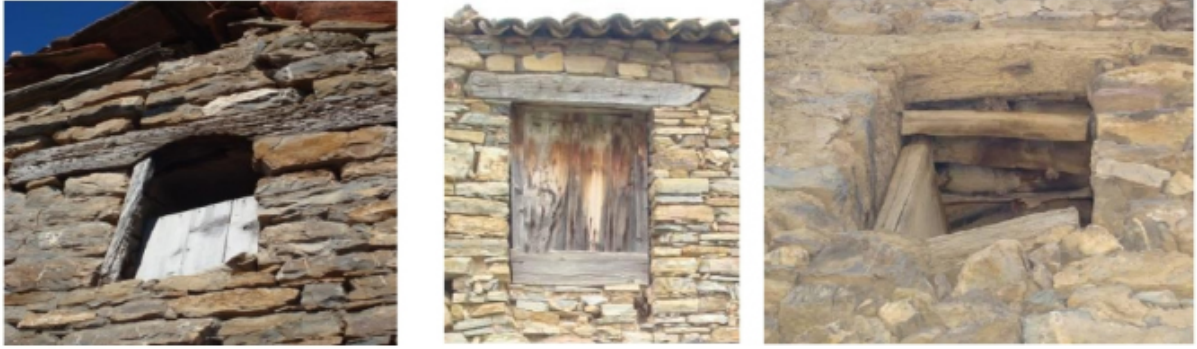
Ces ouvertures sont une simple interruption dans le mur. Elles sont constituées de linteaux en bois A gauche. Village Djebba, Béjaia. Au centre : Mazekwane, Tichy, Béjaia. A droite : Boudjlil, Béjaia
