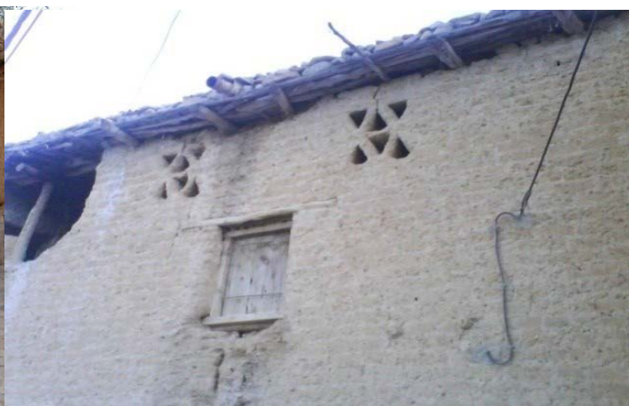
Photo 57 : Les fenêtres de forme rosace Source : Auteur (2016)
