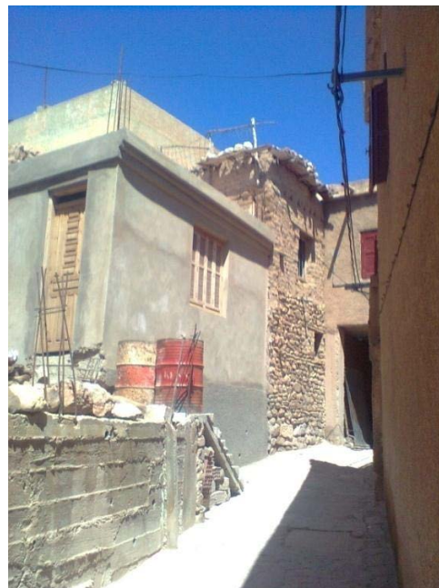
Photo 59 : Nouvelle Construction Source : Auteur (2016)
