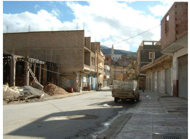
Photo 52: Construction nouvelle à Menâa Source : Auteur (2016)
