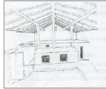
Mise en place des chevrons (Timiway.)
