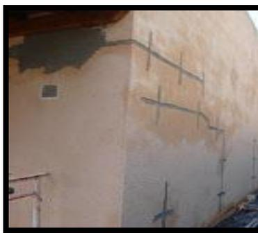
Etape 2 : Traitement des fissures par Injection d'un composant souple
