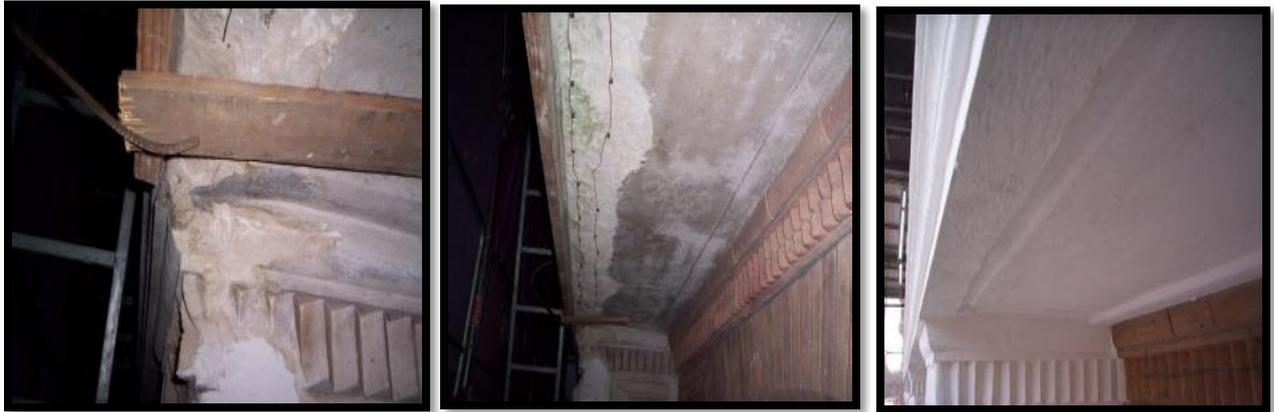
Piquage et préparation du coffrage coffrage et préparation des accroche rendu finale avec traitement à chaux
