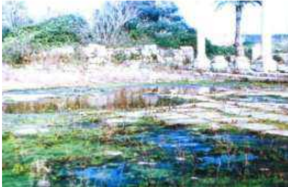
Photo 48 :Affaissement des pavements de forum et retenue des eaux
