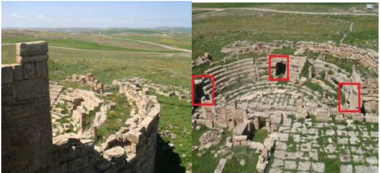
Photo33: Façade du théâtre, Source:auteur, Avril,2016 photo34:Accès du théâtre, Source: auteur, Avril,2016.
