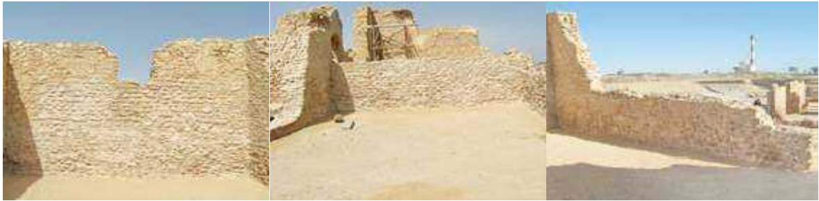
Photo 15 : Avant intervention, Source : http://www.inp.rnrt.tn .
