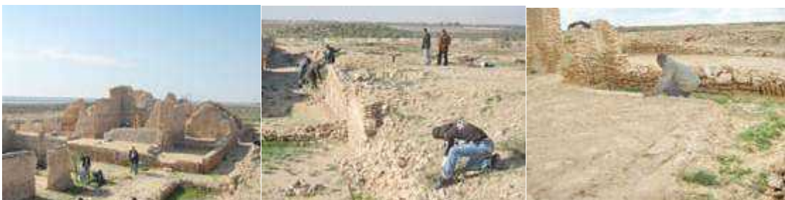
Photo 13 : Avant intervention, Source : http://www.inp.rnrt.tn .
