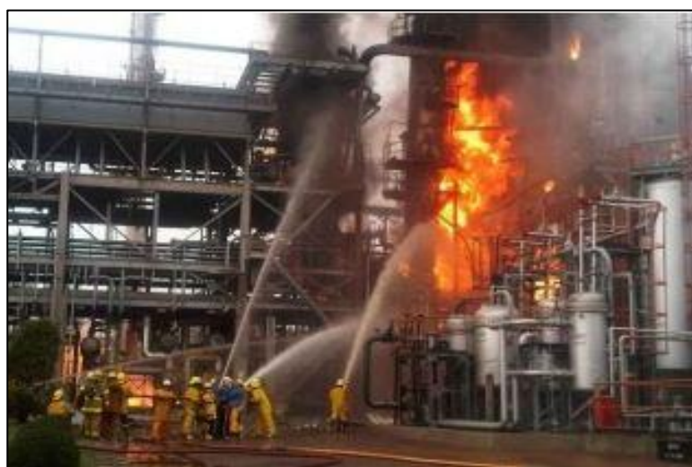
Figure 13 : Explosion dans une raffinerie de pétrole Bangkok
