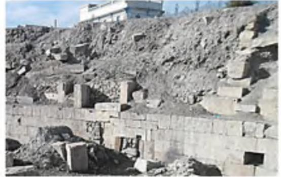
figure 38: effondrement et glissement des assises des gradins
