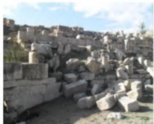
Figure 40: Absence des joints de maçonnerie
