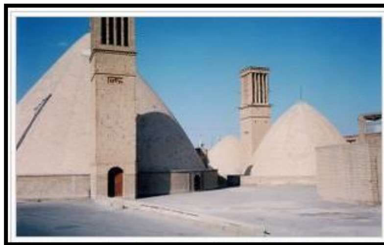
Figure 26 : anbar avec des dômes doubles et capteurs de vent dans la ville De Naen du désert central, près de Yazd, Iran (Source : www.marefa.org/index.php/malgaf )
