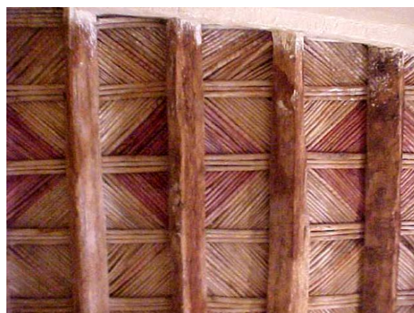
Fig.55 : Lattis serré de tiges de roseau à Bousseghoun
