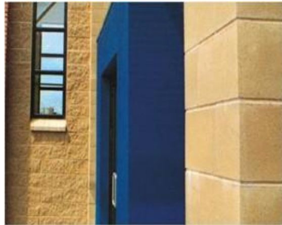
Fig. 28: mur en BTS
