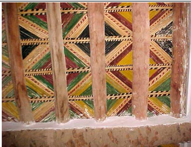
Fig.56 :Décoration du plafond en osier à Boussemgoun
