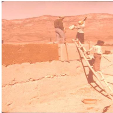
Fig.20: Construction d'un mur en pisé au MAROC
