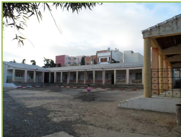
Photo 12 : un revêtement de sol non approprié et source d'accidents.
