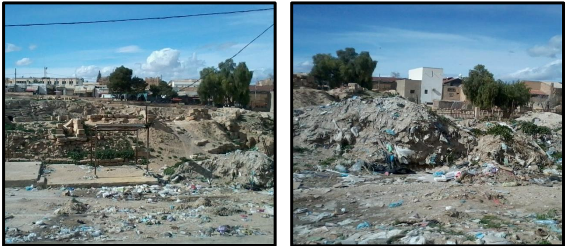
Photo09 : les cumules des déchets produit des obstacles pour les eaux de crues
