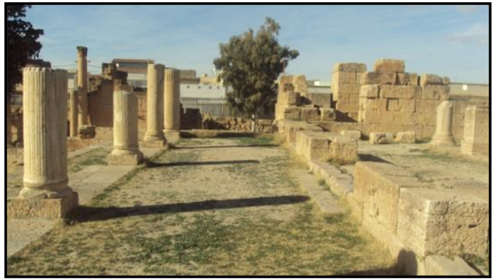
Le reste du portique d'entrée, et l'une des tours qui serve d'escalier (Source –Auteure-)
