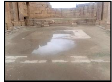
Eau stagnée (Source –Auteur-)
