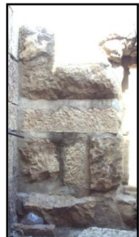
Ciment pour joint et fer pour clôture (Source –Auteur-)
