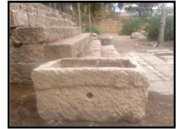
Percement au niveau du perron (source –Auteur-)
