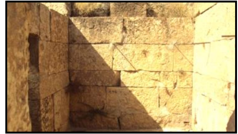
Drains au niveau des murs (Source – Auteure-)
