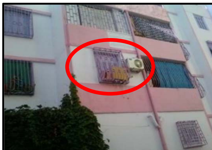
Photo N°27 : Transformation De Balcon A Fenêtre
