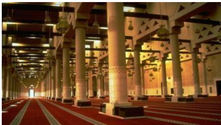
Figure. (2.37): Un plan et une vue intérieure de la salle hypostyle de prière, montrant les ouvertures triangulaires utilisées pour l'éclairage et la ventilation naturelle. (Source: Archnet.org)
