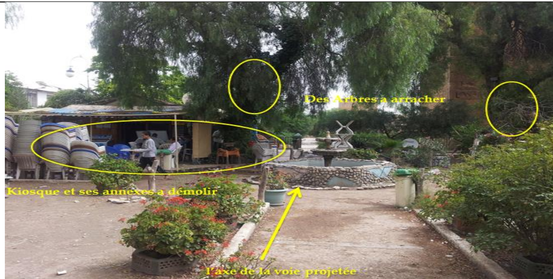
Photo 20 : d'autre kiosque à démolir dans le coté de porte de Caracalla.
