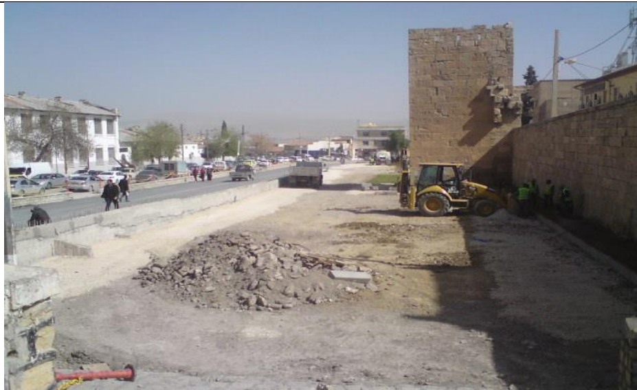
Photo 24 : après l'opération de remblais.
