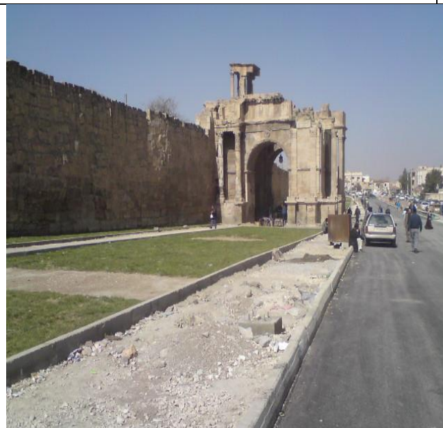
Photo26 : la nouvelle voie pré de la muraille.
