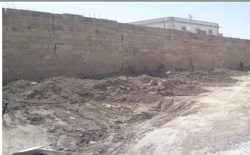
Photo 22: le décapage de la terre végétale.
