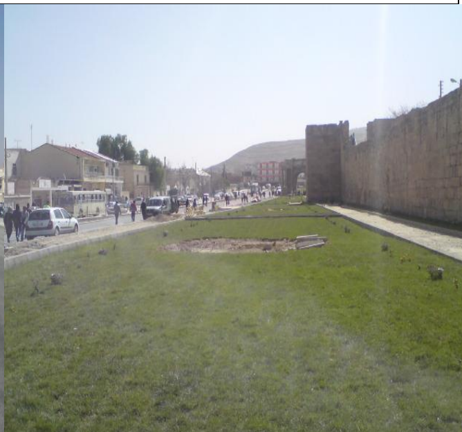
Photo 27 : l'installation du gazon.
