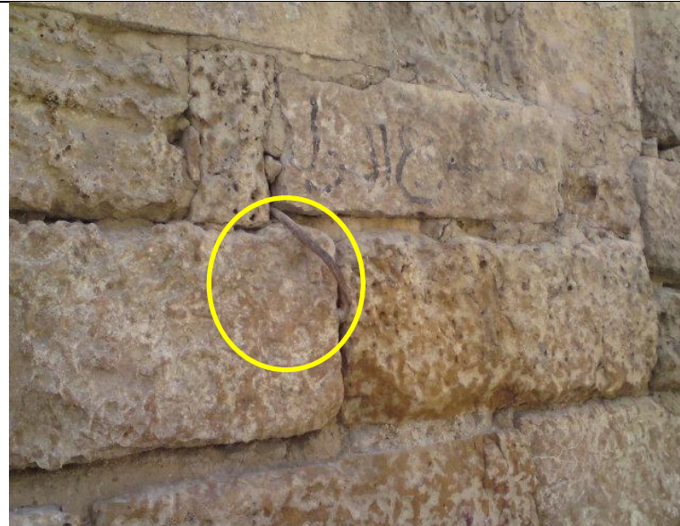
Photo 42: les barres de fer entre les pierres.
