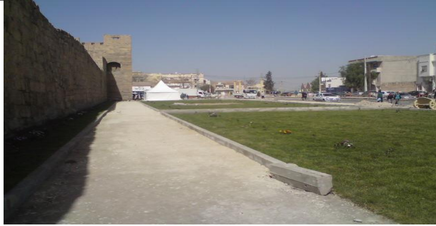
Photo 25: après les travaux d'aménagement.
