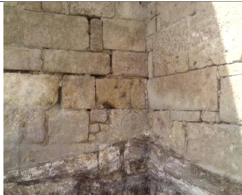
Photo 47: les partis de rejointement.
