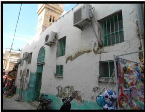
Figure n°61: façade nord Source : auteur
