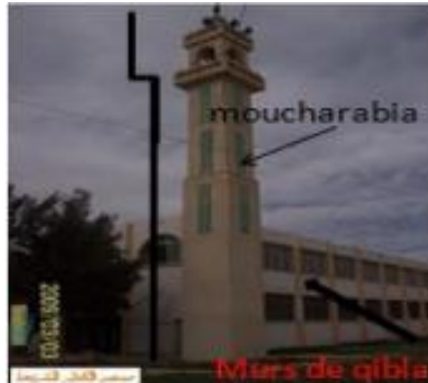
fig n°73 :la minaret de mosquée ElKhaouther source auteur
