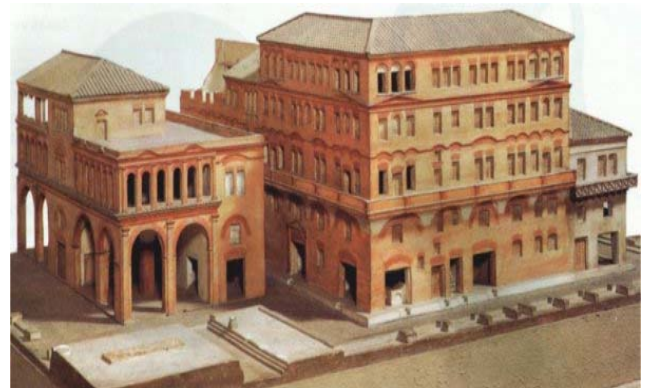
Figure II.10 : Immeuble collectif (Source : Google image).
