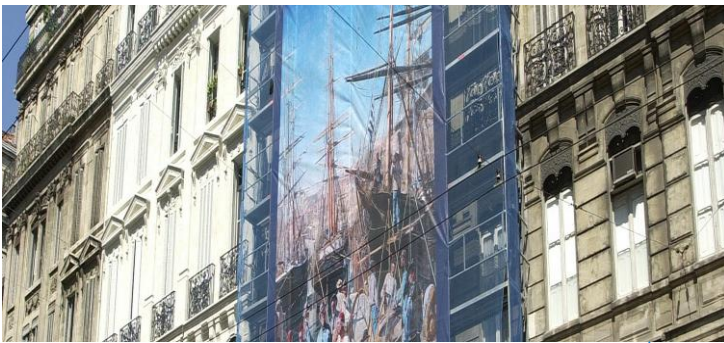
صورة رقم 10: ترميم الواجهات
