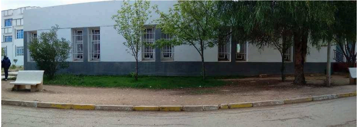
Figure n°21 : photo panoramique de l'amphi 5, façade nord-ouest
