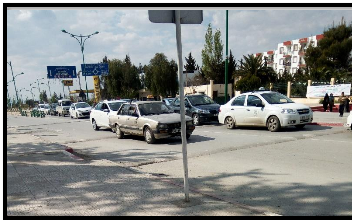
Image n° 14 : la sortie de la trémie vers le centre-ville.
