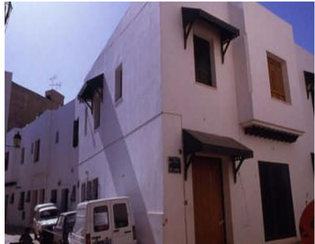
Photo.10: Réhabilitation des bâtiments 21 .
