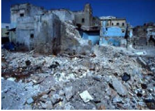
Photo.07 : État de ruine du quartier 18 .
