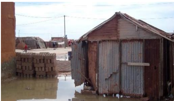
Photo.24: Les problèmes d'assainissement 34 .
