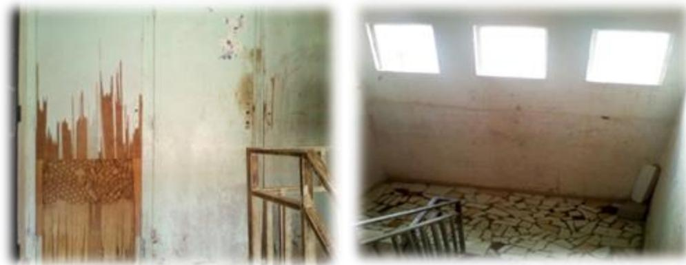
Photo 11 : Portes des placards et châssis en mauvais état
