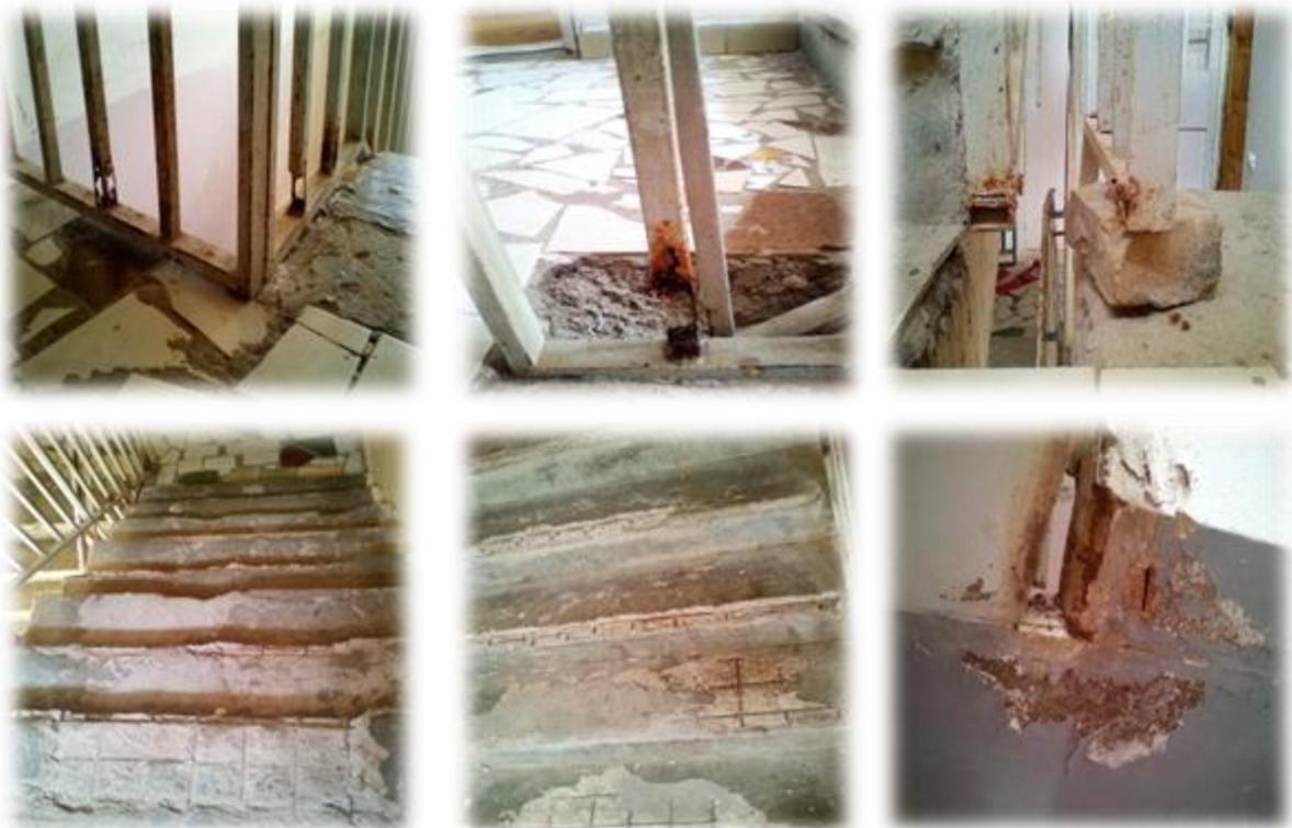
Photo 09 : des marches cassées et des garde-corps rouillé et pas fixé
